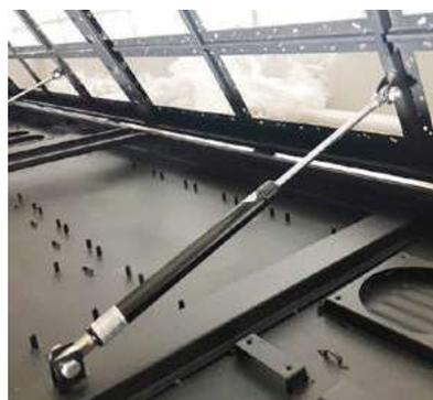
**Apertura delantera** con sistema de elevación amortiguada
